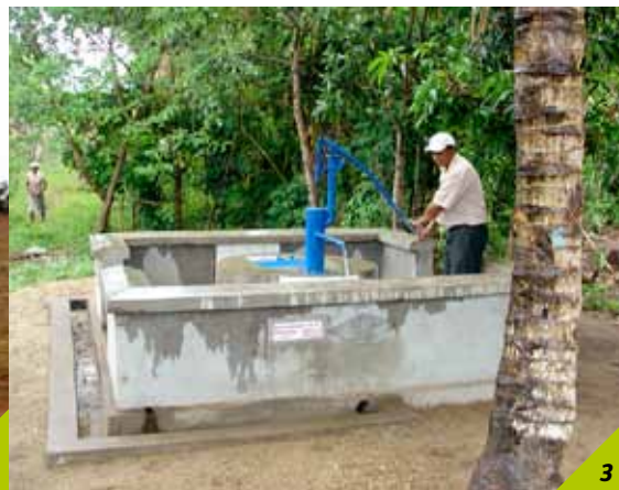
3 - Puits avec pompe manuelle
