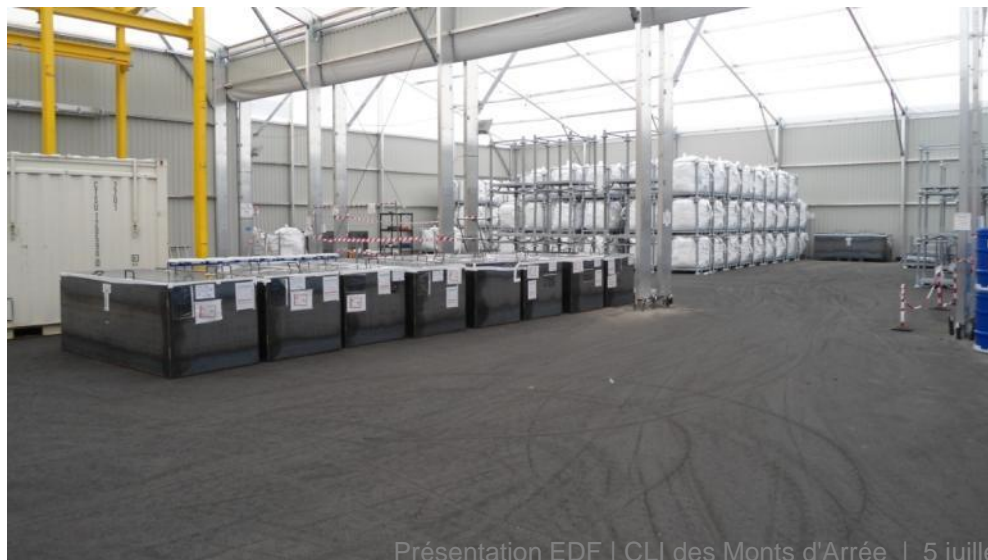
Abris à colis pour la mise en conteneur des big bags
