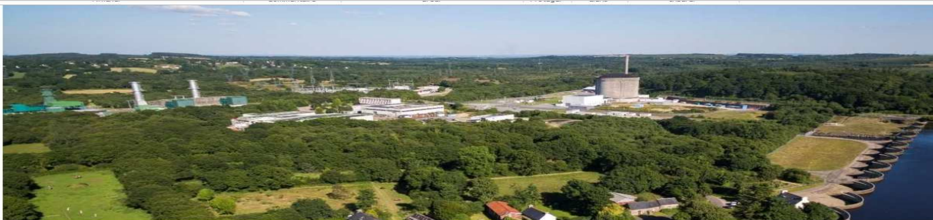
Vue de la centrale dans le paysage des Monts d'Arrée © V. Roncheray
