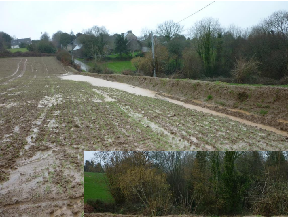
Finistère 2011, rupture de talus à rôle hydraulique nouvellement construit
