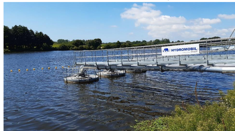
Nouvelle prise d'eau dans la retenue du Moulin Neuf CCPBS, 2024
