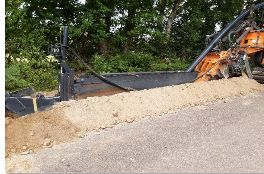
Mise en place d'une interconnexion entre Berrien et Scignac – 2023
