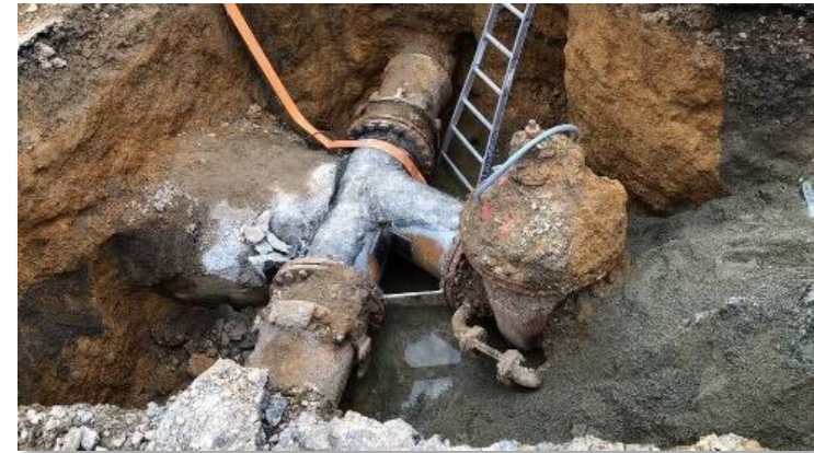
Travaux de réparation suite à une casse SMA, 2024
