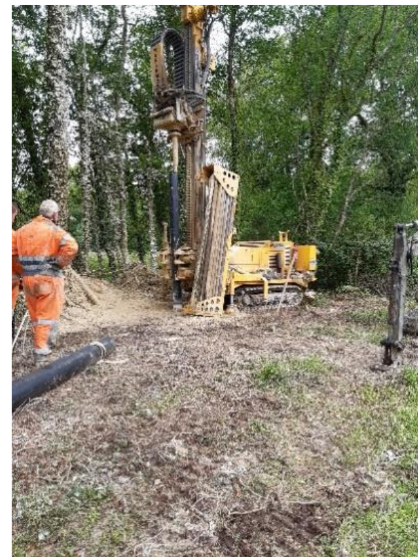
Forage de reconnaissance réalisé à Berrien – 2023
